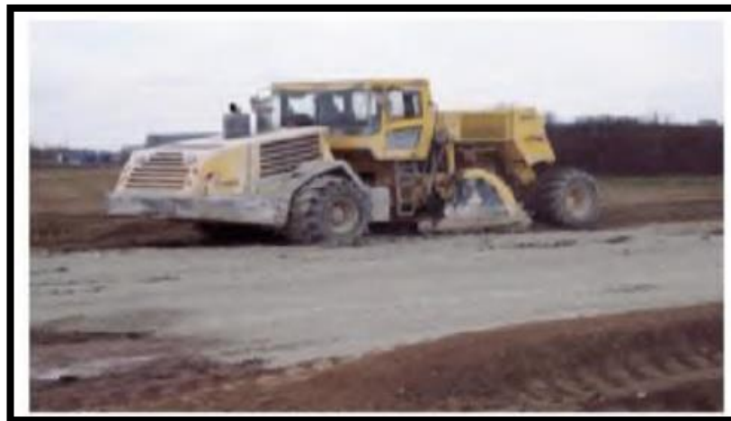
Figure 47 : Chantier de traitement du sol au ciment. [27]
