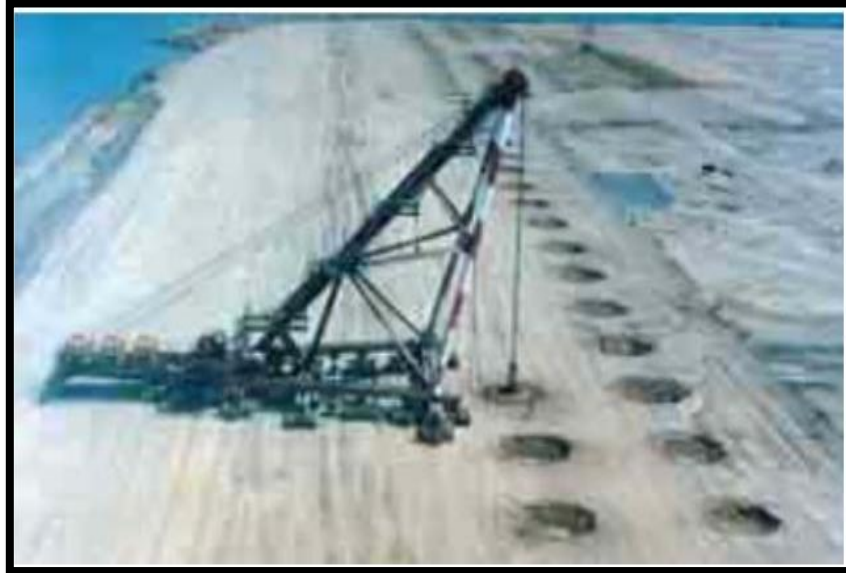
Figure 35 : Chantier de compactage dynamique (aérodrome de Nice-France)
