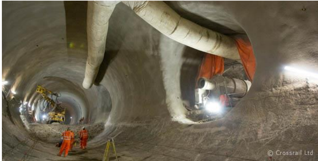
Figure 2 .Nouvelle méthode autrichienne de tunnelage (NATM) [6]
